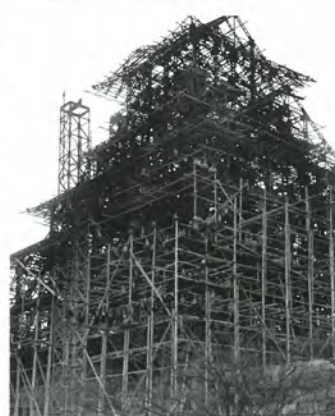
▲ 建設中の大阪城天守閣 昭和6年（1931年）
