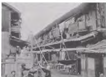
市内の不良住宅
